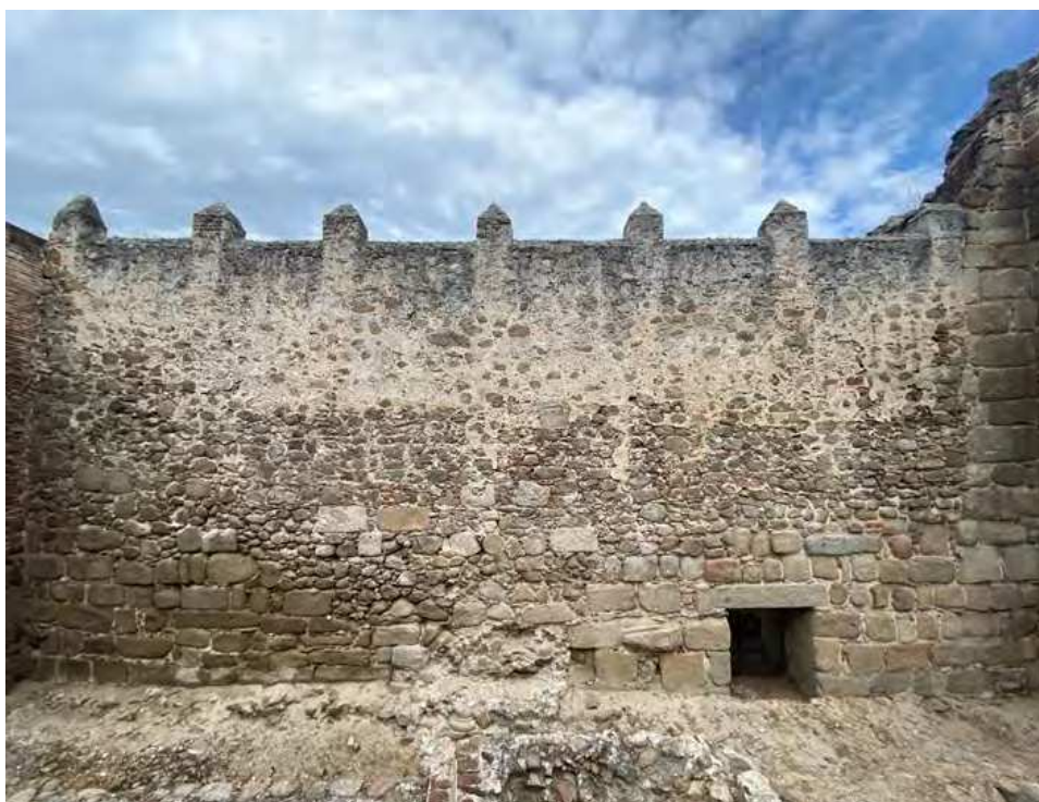
Fig. 3. Vista del muro exterior de la muralla entre las Torres T- y T-1 (Autores)
