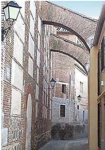
M. Bernardas: arbotantes de refuerzo laterales (C/ S. Bernardo).
