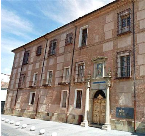
Asilo S. Prudencio: fachada principal.
