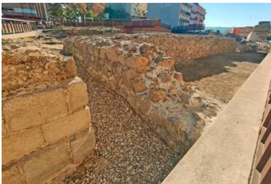
Figura 5. Tramo de la barrera-antemural en codo junto a la torre albarrana de la Puerta de Mérida (A. Moraleda).
